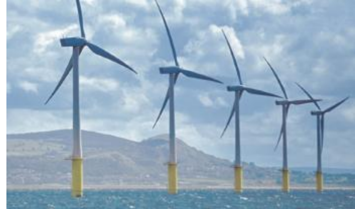
Windkraftanlage Rhys Flats
