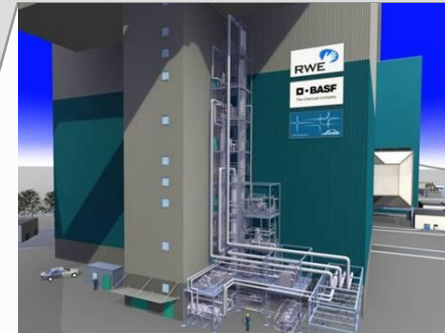
CO 2 -Wäsche; Versuchs- betrieb ab 2009 ⇒ CO 2 -Abtrennung
